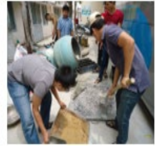
Hình 8. Cát trộn bê tông xỉ thép tự đầm.
